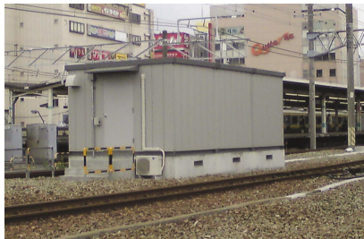
●踏切制御子収容箱 器具箱(踏切制御用)
