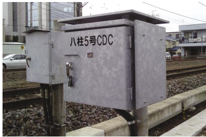
●踏切制御子収容箱 器具箱(踏切制御用)
